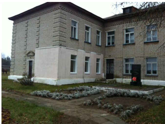
Fig.14 il plesso scolastico di Macesk e in primo piano la parte di edificio destinata ai servizi igienici, costruiti negli anni 2009-2010 ad opera di Smile.
