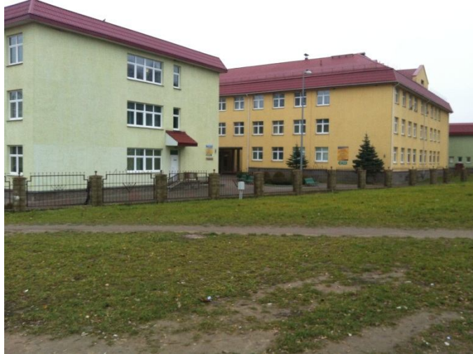
Fig.3. I tre padiglioni che costituiscono l'ospedale pediatrico di Minsk n.2
